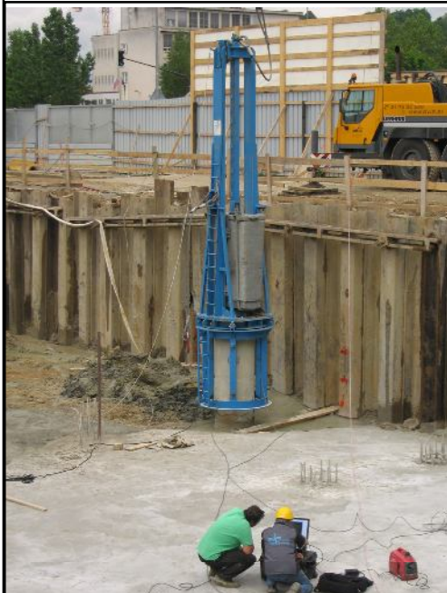
Dinamični obremenilni test na CFA pilotu
