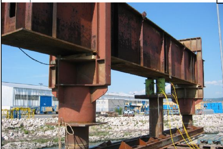
Statični obremenilni test z izvlečnimi piloti
